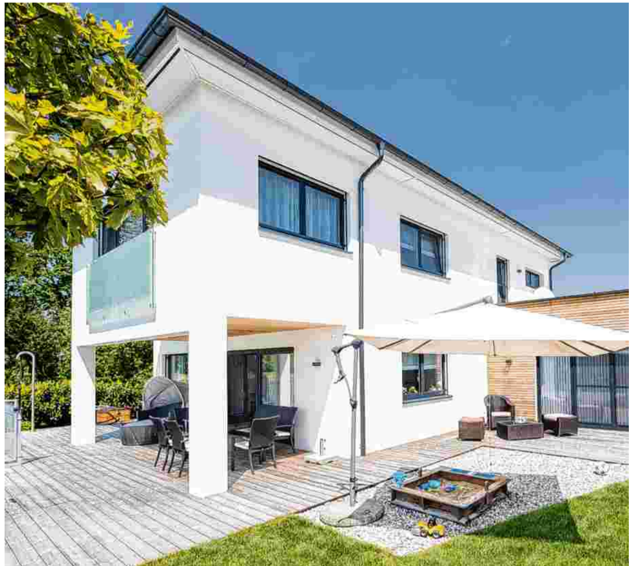
Der Baustoff Holz ermöglicht die Vorfertigung ganzer Wandelemente, die vor Ort in wenigen Tagen montiert werden. Individuelle Planung, Fix-Preis und Fix-Termin sind für das Fertigteilhaus charakteristisch. Fotos: Genböck Haus
